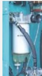
Filtro principal de combustible
